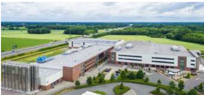
Germany, Plant 3: Pöppelmann GmbH & Co. KG, Lohne/Brockdorf
